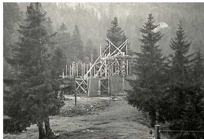
Die Marienkapelle auf der Ibergeregge im Bau: Die Grundsteinlegung erfolgte am 6. August 1960.
